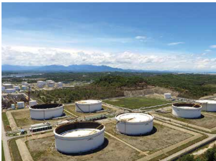
Khu bể chứa dầu thô của Nhà máy Lọc dầu Dung Quất. Ảnh: BSR
